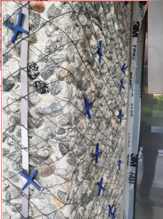
Bilde 15 - Eksempelbilde etter utmeisling, montering av
