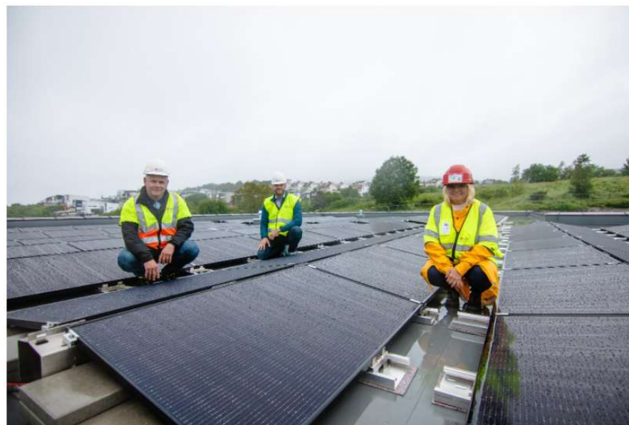
Ole Arne Torsvik (energirådgiver), Jesper Brodersen (leder FDVU) og Sissel Olga Pettersen (prosjektansvarlig) i Bodø kommune er svært fornøyde med at nye Mørkvedbukta skole og barnehage har Bodøs største solcelleanlegg på taket. Foto: Per-Inge Johnsen/Bodø kommune
