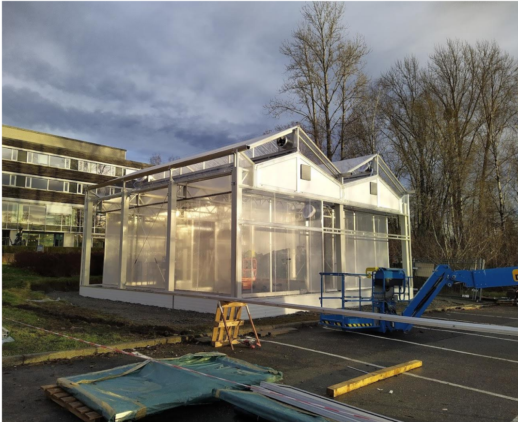
Bobleveksthus – isolert med såpebobler
