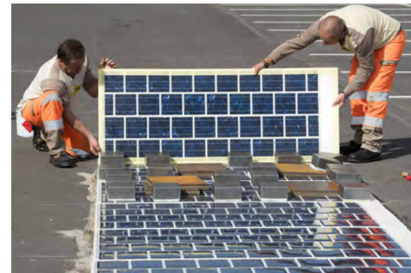
Det arbeides med 1.000 km sykkelsti Frankrike belagt med solcelle'asfalt'.
