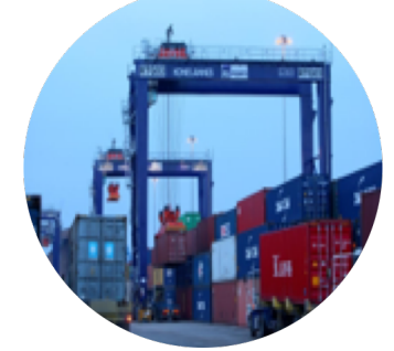
Havnekraner og landstrøm stasjoner
